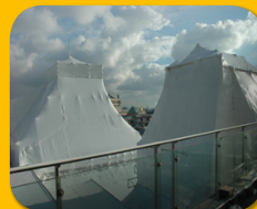
Witterungsschutz bei Baumaßnahmen
