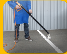
Thermoplastische Fahrbahnmarkierung
