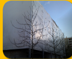
Asbestsanierung
