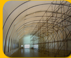
Temporäre Abdeckung von Strukturen
